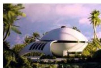
Le case sono prefabbricate usando un nuovo tipo di cemento armato presollecitato, con un rivestimento esterno di ceramica flessibile; sono praticamente esenti dalla manutenzione, antincendio e impenetrabili agli agenti atmosferici. I loro magri assemblaggi a guscio potrebbero essere prodotti in serie in poche ore; con questo tipo di costruzione, il danno provocato dai terremoti e dagli uragani è minimo.
